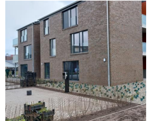
Errichtung von E-Ladesäulen im Wohnungsbestand
