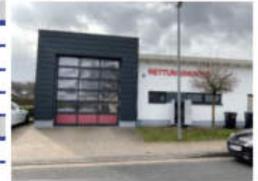
Abbildung 31: Außenansicht Rettungswache Visselhövede
