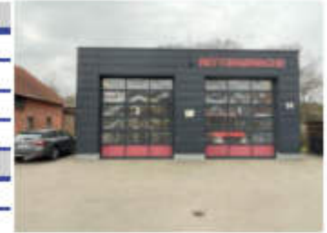
Abbildung 26: Außenansicht Rettungswache Lauenbrück
