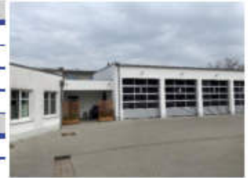
Abbildung 24: Außenansicht Rettungswache Bremervörde
