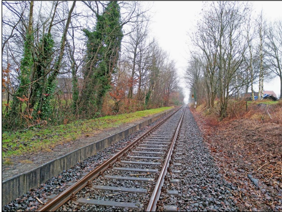
Hagen in Richtung Stade [eigene Aufnahme]
