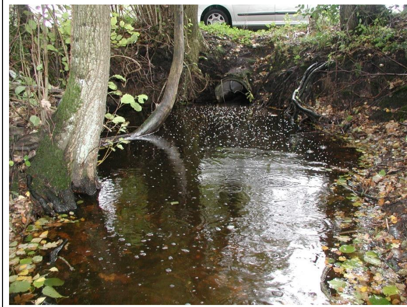
Windershuser Abzugsgraben, Einleitstelle 2012
