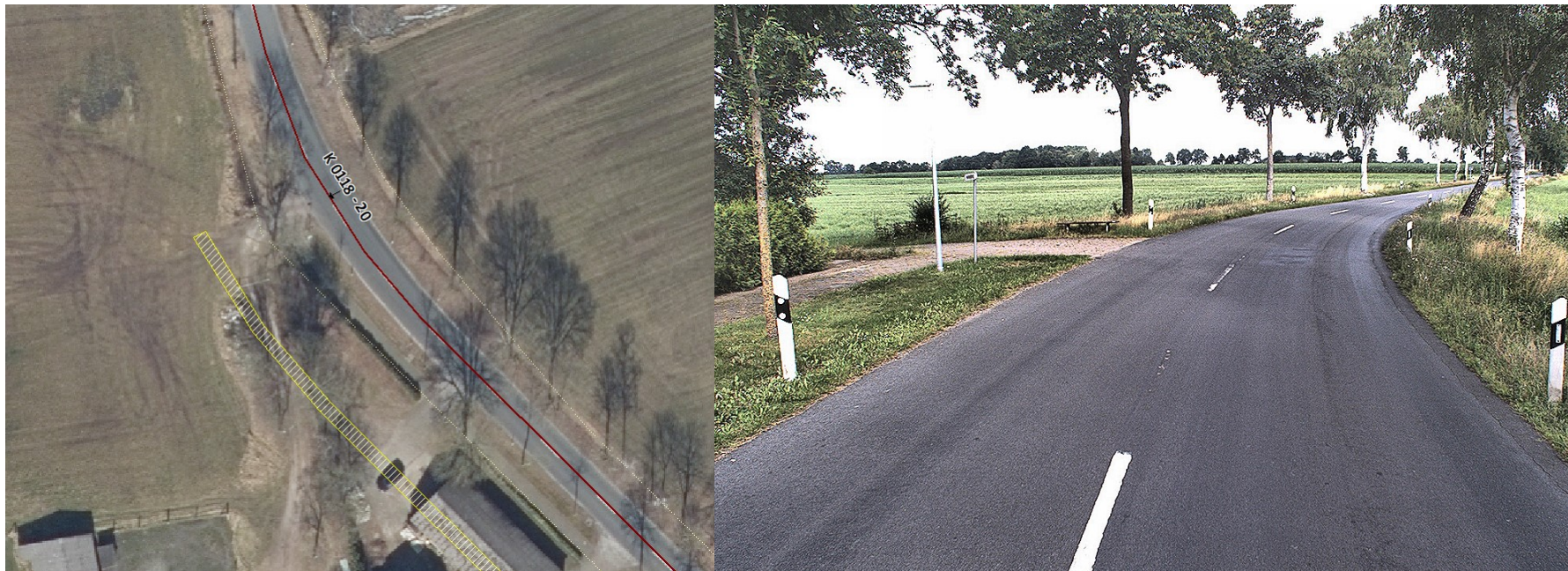
Beispiel: Ende eines straßenbegleitenden Radweges an der K118-20, OD Fiehnberg, Ohrel (Gemeinde Anderlingen)
