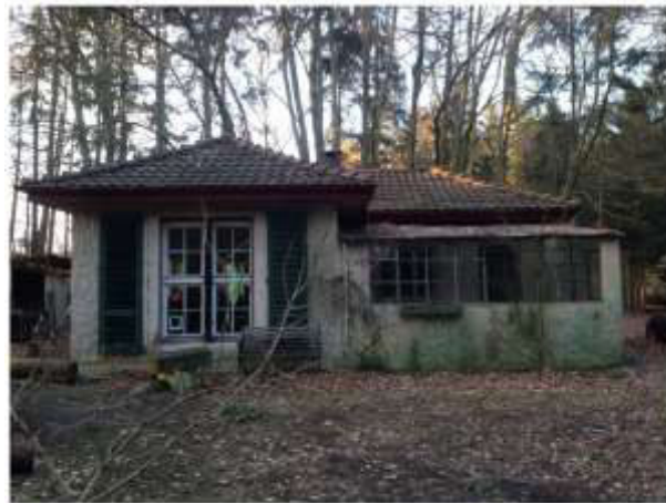
Bild 6: Gebäude im Wald östlich der K 113 zwischen Wilstedt und Buchholz
