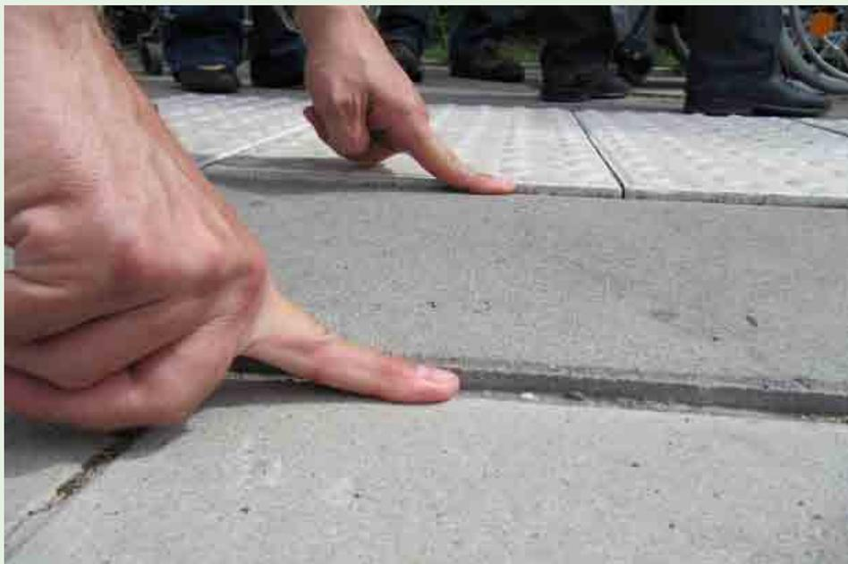
Bild 32: Einbau von Bodenindikatoren und Sonderbord mit zu großer Einbautoleranz
